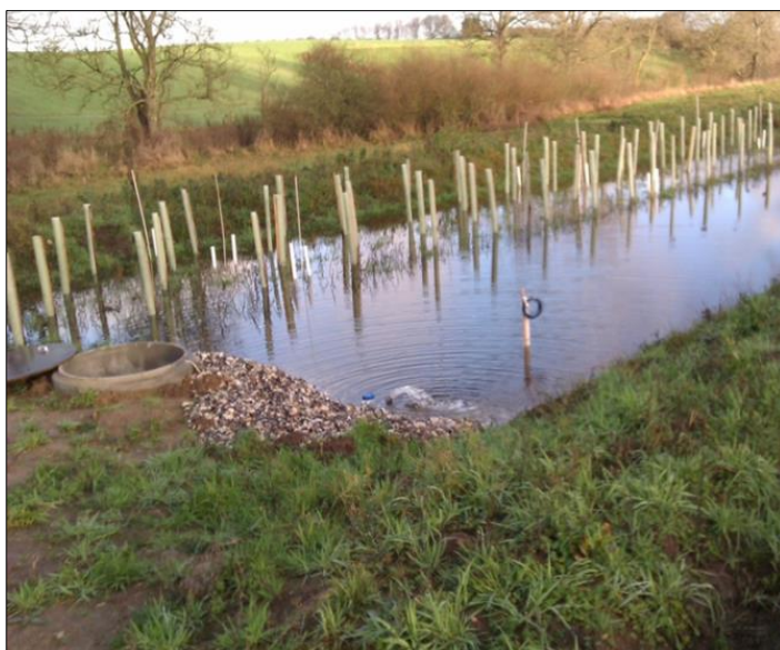
Foto: IBZ anlægget ved Fillerup med flowmeter i indløb, tryktransducerer til måling af vandstand i anlægget, de hvide piezometerrør og de plantede elletræer beskyttet af en plastickappe.
