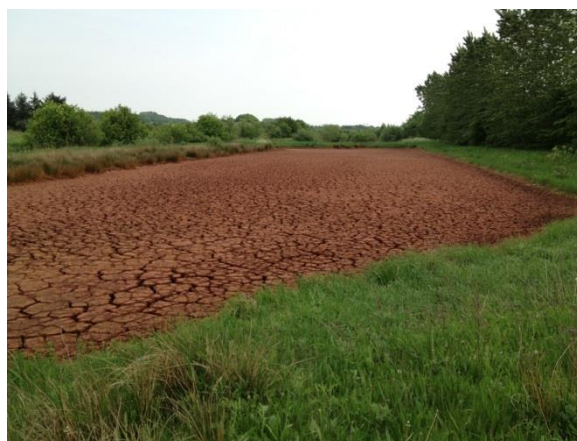
Okkeranlæg ved Spåbæk. Jernslam herfra har gode adsorptionsegenskaber for fosfat. Foto: Henning S. Jensen.
