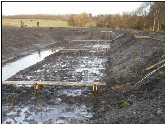
Billedet viser de gangbroer der er sat op for at der kunne sættes pejlerør op til vandprøvetagning.
